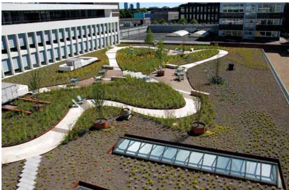
Deze daktuin is door Polderdak aangelegd in Amsterdam.
