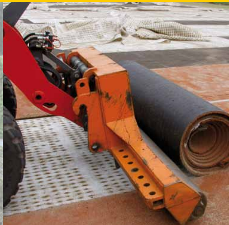
Is de snijder eenmaal ingeklapt, dan worden de losgesneden stukken mat opgerold door dezelfde shovel. De rollen zijn 25 meter lang en twee meter breed.
