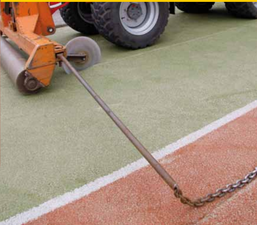
Var verwijdert bij TC De Linden in Beuningen een kunststof tennismat. De mat wordt in banen gesneden door een snijder aan de voorkant van de shovel.
