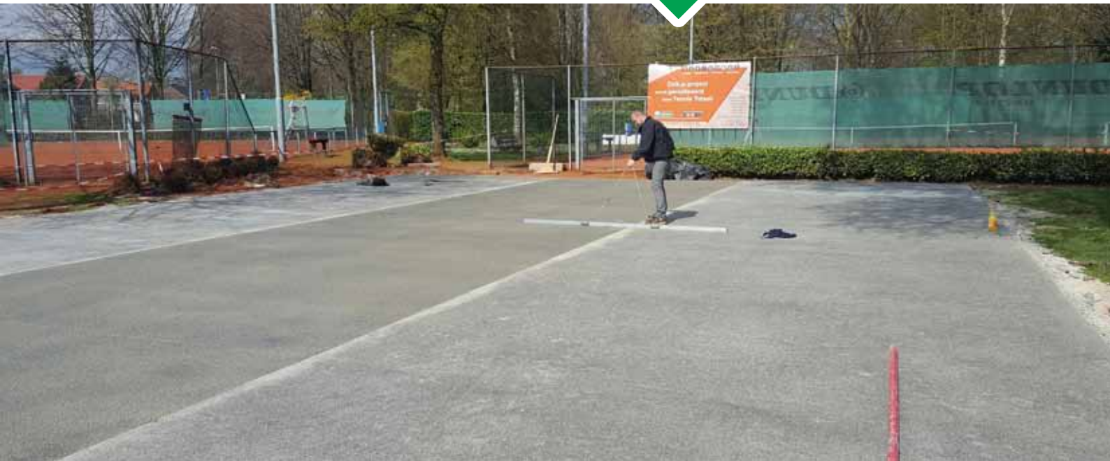
Het uitvlakken van een Padelcourt is essentieel voor de kwaliteit van de baan.
