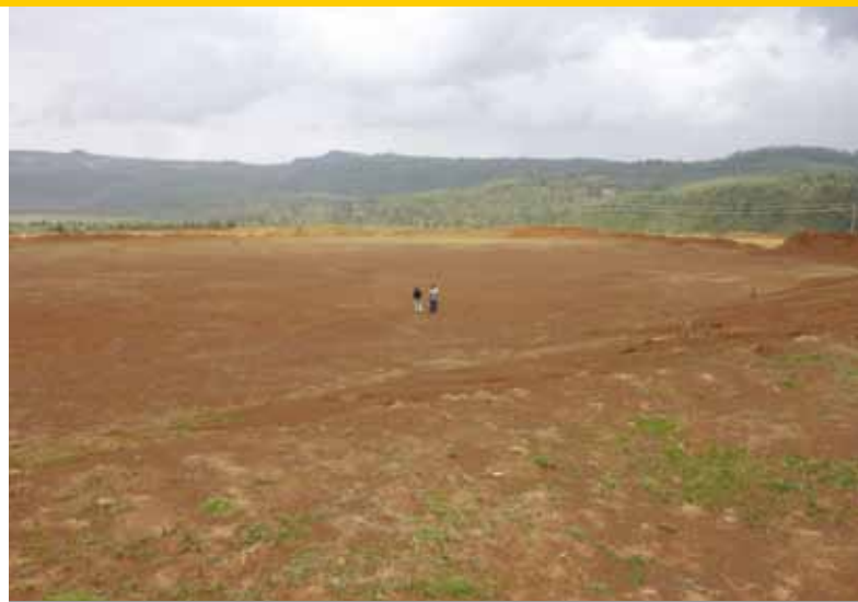
Grondwerk operatie geklaard net voor het regenseizoen.
