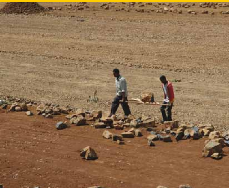
Plaatselijke arbeidskrachten worden ingehuurd om buitensporig grote stenen van het bouwterrein te verwijderen. Zwaar werk maar het zorgt voor brood op de plank.
