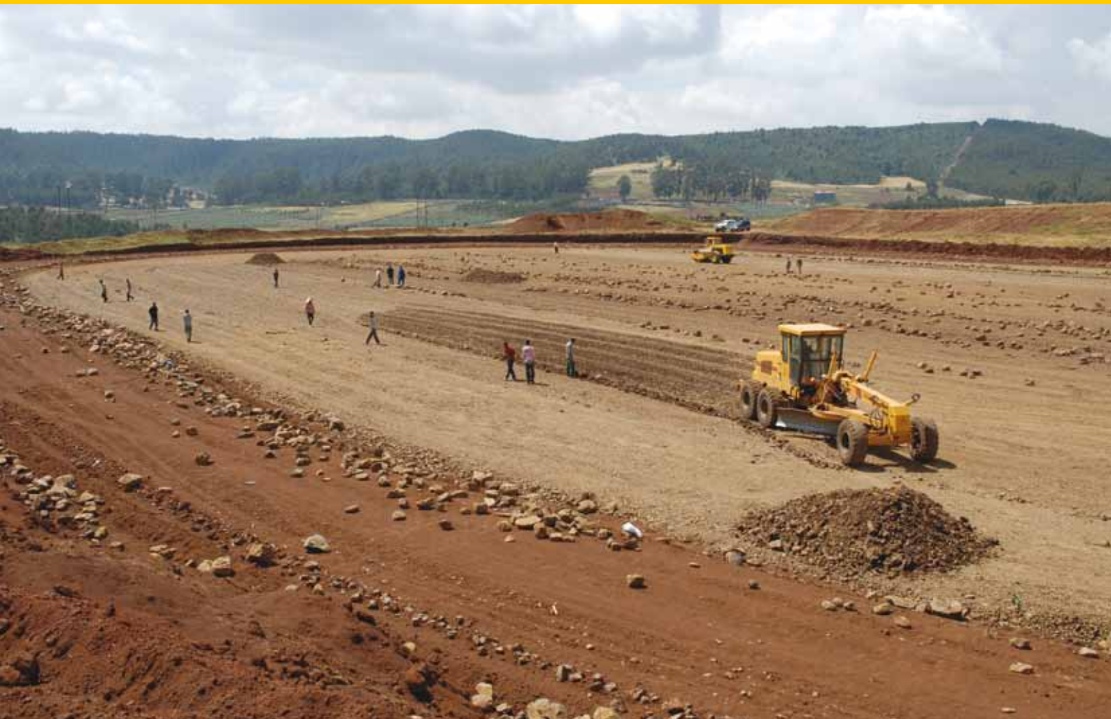
Geselecteerd vulmateriaal wordt toegevoegd om de kleiformatie af te dichten.
