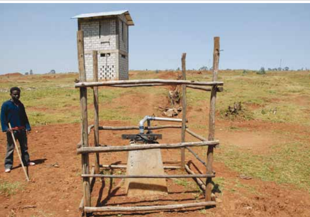
Pompstation en ondergrondse put voor het winnen van beregening water op 120m diepte.
