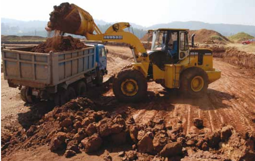
Ontgraving van de klei voor de toegevoegde halfverharde trainingsbaan.
