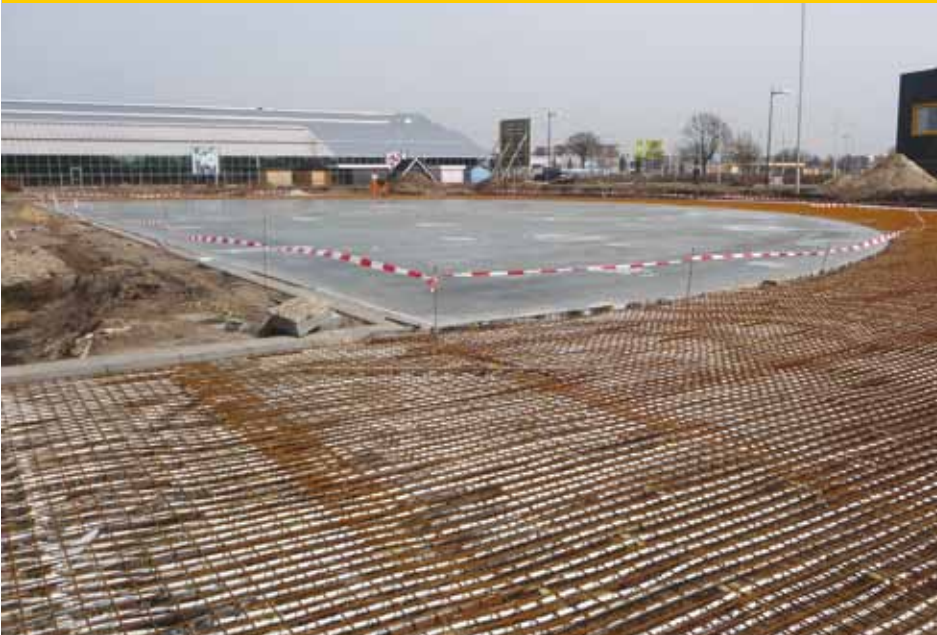
1. 20 centimeter onder de toplaag van het sportveld wordt het (koel)leidingennet met zijn wapening aangelegd. Wat niet te zien is, zijn de acquiers – de leidingen die verticaal de grond in gaan.
