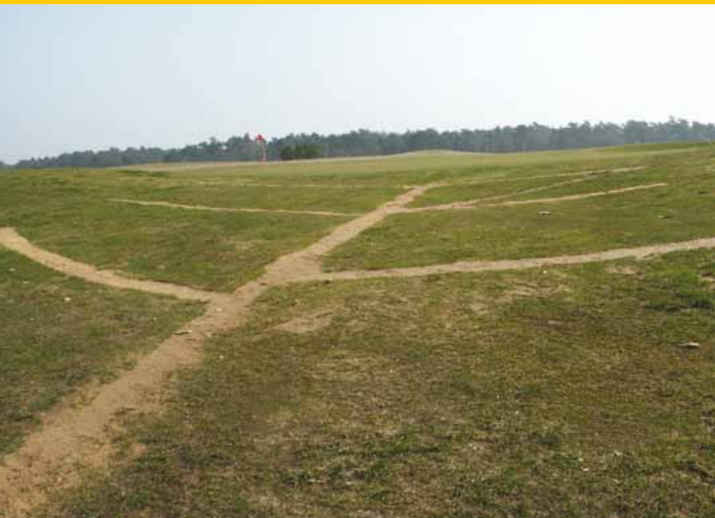
Bij een visgraatdrainage monden de zuigdrains via een Y-stuk uit op een hoofddrain.
