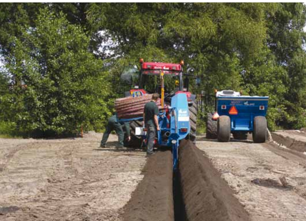
Bij aanleg wordt de drain in het zand gelegd. (Foto dank aan Elco).
