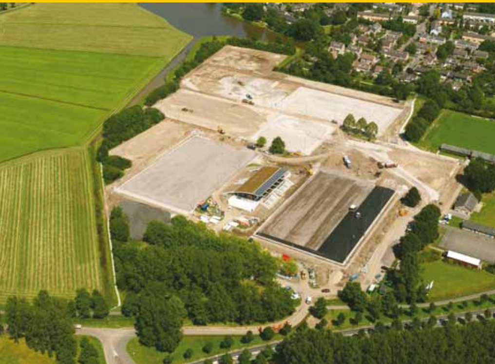
De bouwwerkzaamheden van bovenaf gezien.
