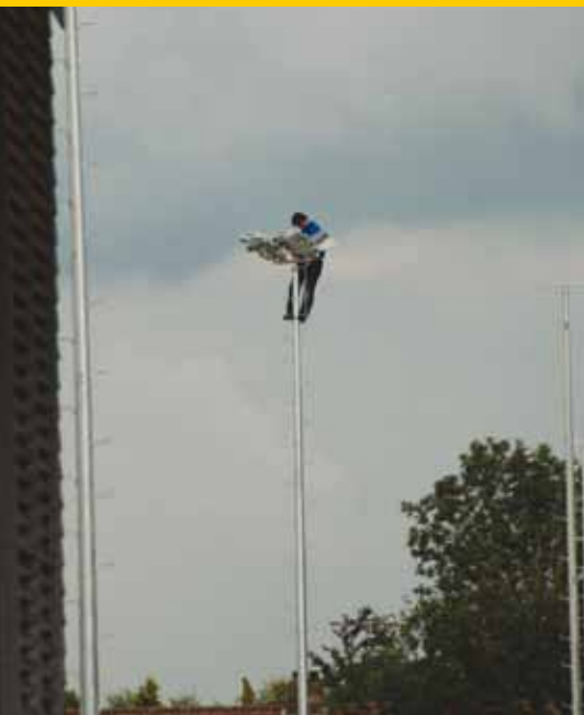
De led-verlichting wordt geïnstalleerd.
