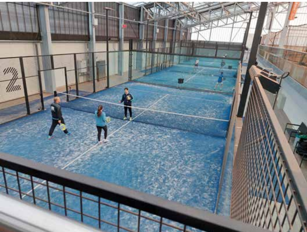
Op de recent in gebruik genomen banen glinstert het instrooizand nog aan de oppervlakte. Goed te zien is waar het inlopen het snelst gaat en dus ook de belasting van het veld het grootst is.
