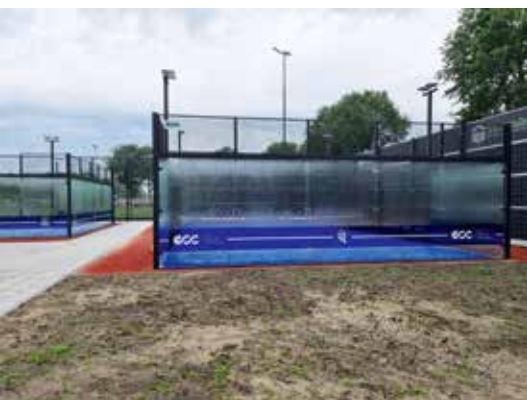
Rechts een stuk van de 62 meter lange geluidsmuur in Moergestel.
