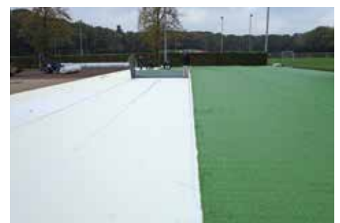
Installatie Ten Cate Total Solutions shockpad op De Zweef, Nijverdal
