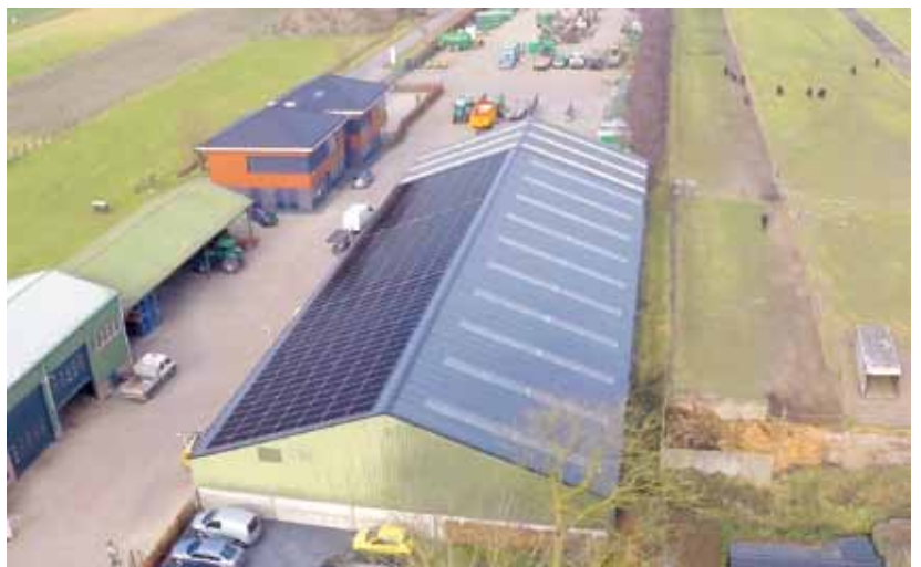
Bovenaanzicht van de materieelberging van Van Wijlen. Deze is eind 2015 voorzien van 555 m 2 zonnepanelen.
