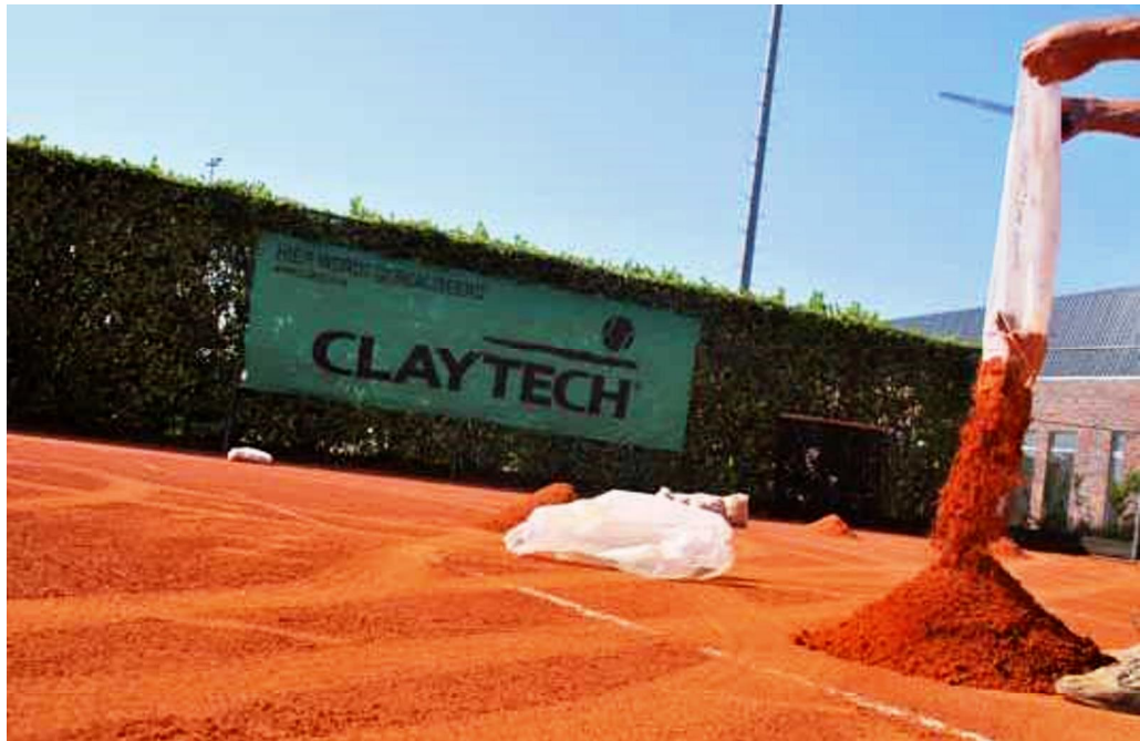
De onderlaag wordt afgestrooid met gravel
