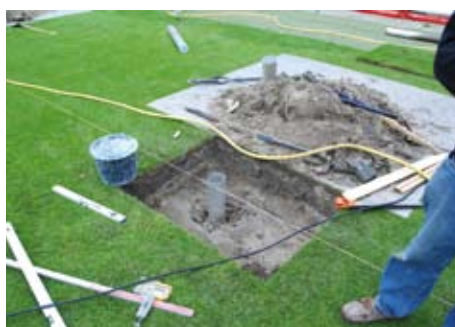
De speerfundatie met drie vinnen, waarmee de doelpalen op handige wijze onbeweeglijk in de bodem worden geplaatst. De bodemplaat ligt hierbij een stukje onder het maaiveld.
