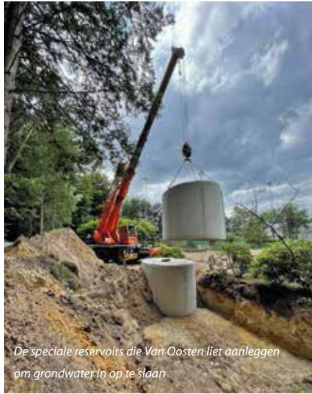
De reservoirs kunnen twintig kubus water bevatten en worden gevoed door een grondwaterpomp van de voetbalclub.
