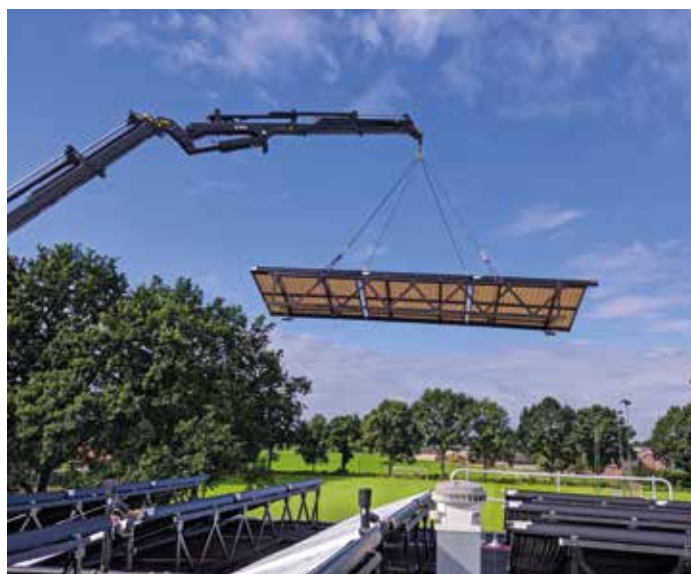
De zonnecollectoren worden op het dak gehesen.
