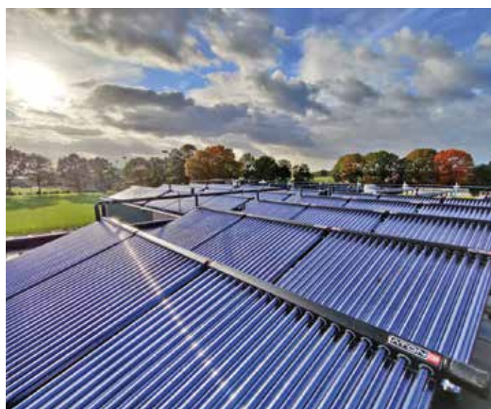
De zonnecollectoren zijn aangesloten en functioneel.
