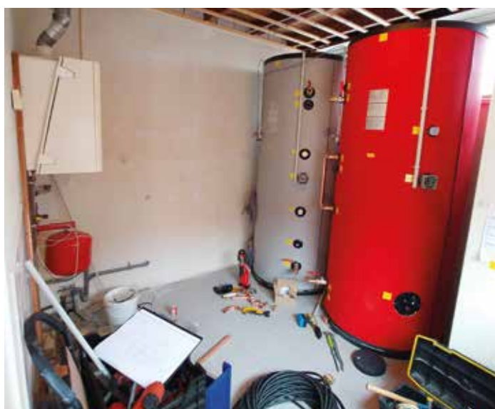
Het plaatsen van buffervaten om 's avonds te kunnen douchen
