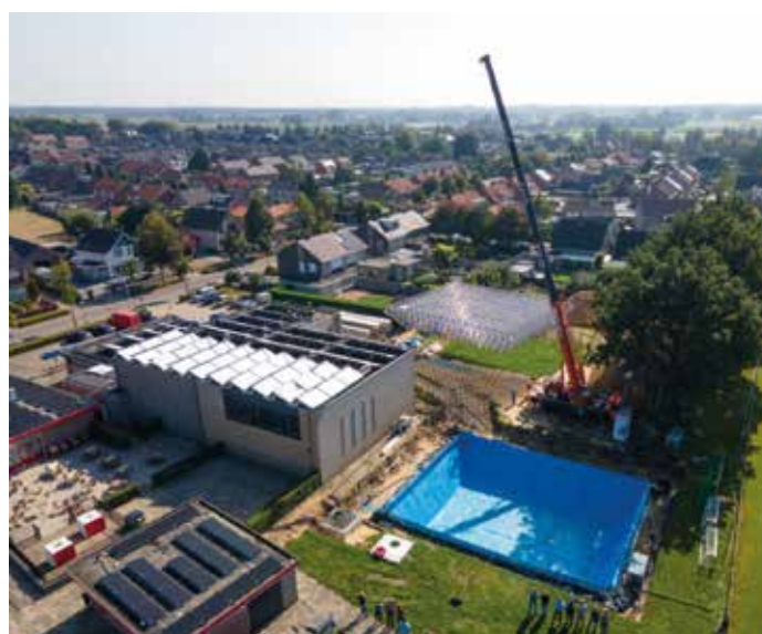
Het spaceframe wordt in het gat aangebracht met een telekraan. Foto: Stef Foesenek
