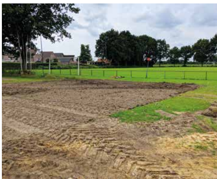
De waterbuffer, afgedekt met grond
