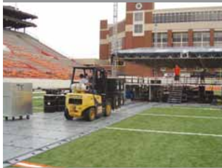
Protrack voor transport in materiaalaanvoer bij het opbouwen van een podium.
