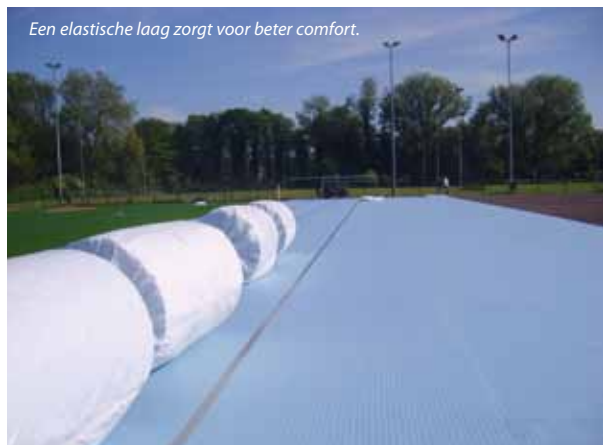
Vlakheid van de onderbouw is cruciaal.
