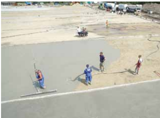
Schuimbeton als oplossing voor aanleg in zettingsgevoelige gebieden.
