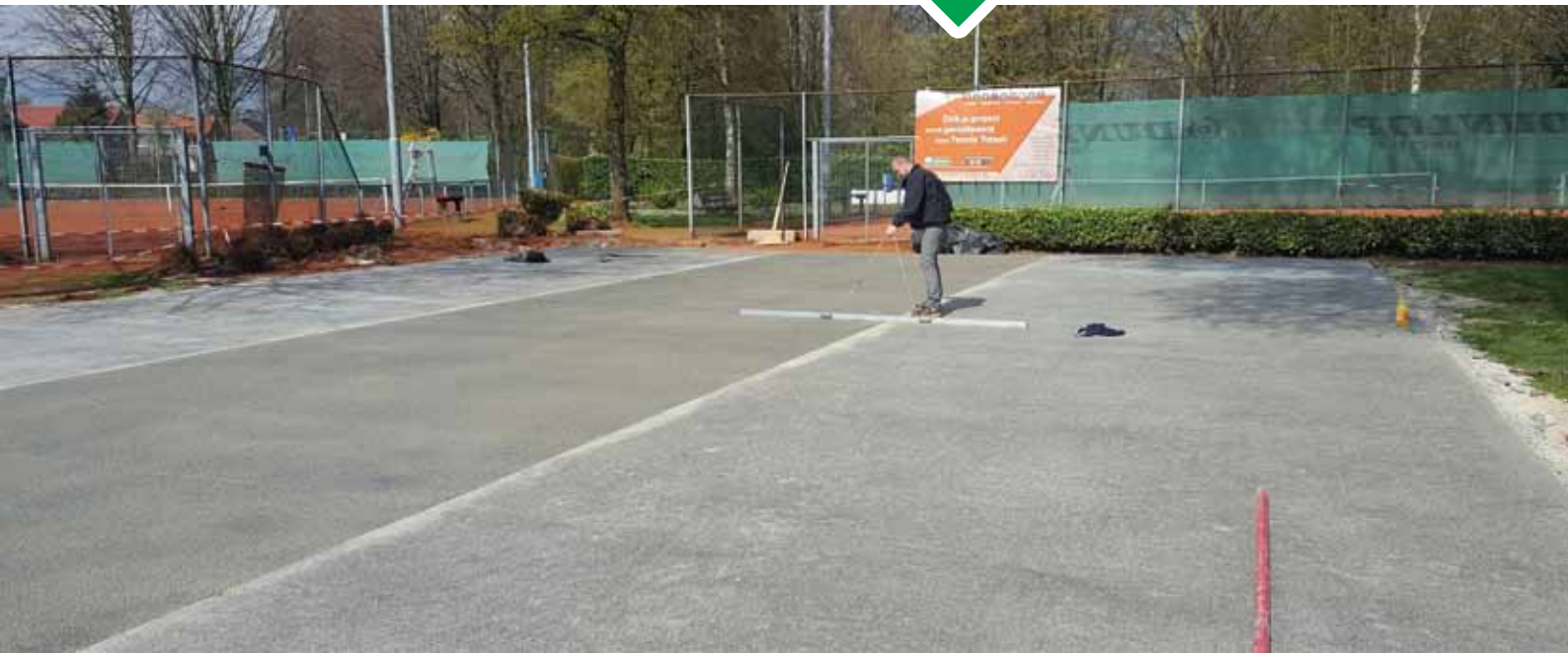
Het uitvlakken van een Padelcourt is essentieel voor de kwaliteit van de baan.
