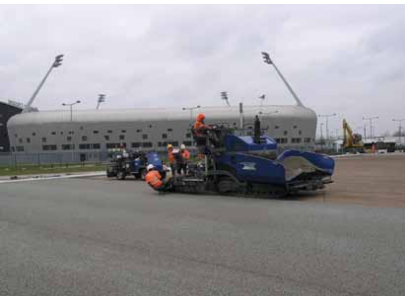
Ook voor Fieldrain wordt mortel gebruikt.
