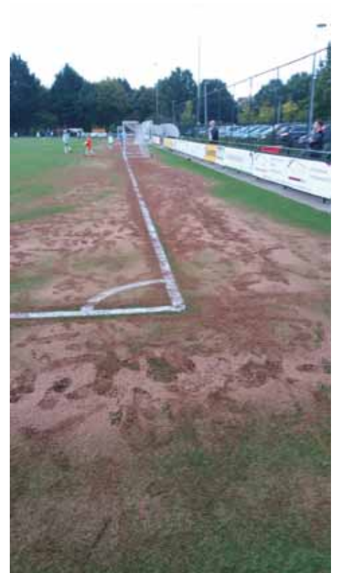
Het kurk-infill op een veld in Lelystad dreef na een hoosbui naar boven en naar de randen. Marcel van Stralen van Sportbedrijf Lelystad: 'Je kunt het kurk-infill in een mum van tijd weer terug de mat in slepen of borstelen. Ook lopen de spelers het vrij snel weer in, getuige de voetsporen op deze foto.'
