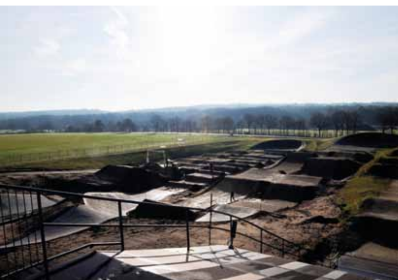
Overzicht over baan in aanleg vanaf de top van de ramp.
